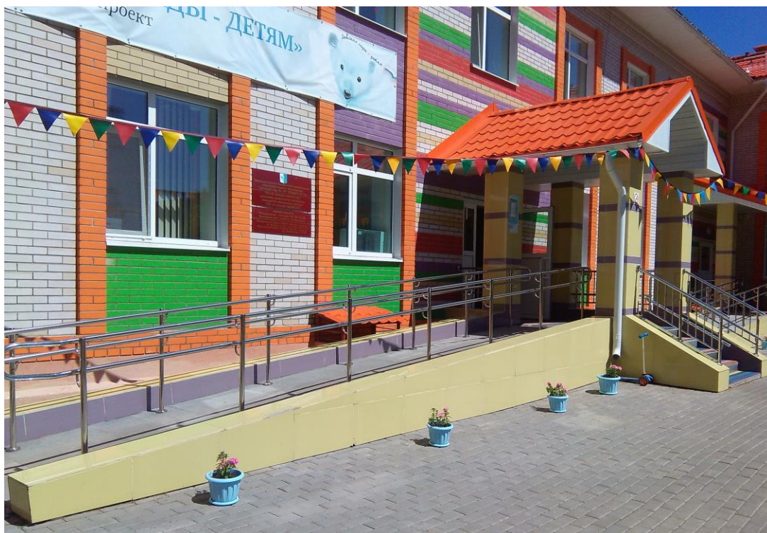
№ 2.1. Вход в здании ДОУ. Пандус. Входная площадка.
