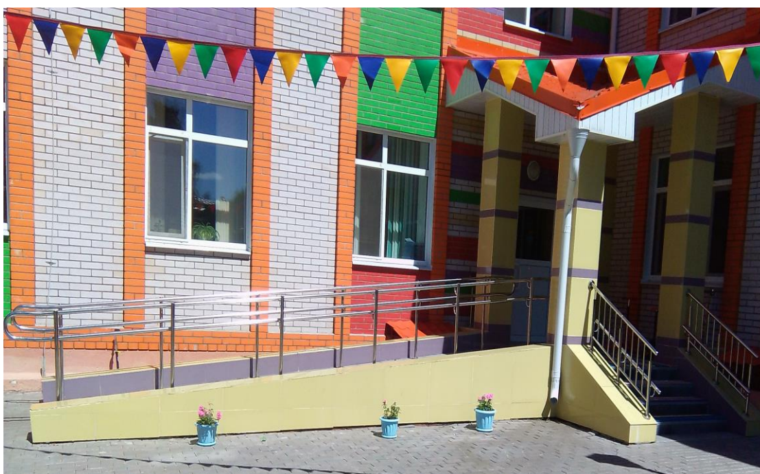
№ 2.2. Вход в здании ДОУ. Пандус. Входная площадка. (1 младшая группа)
